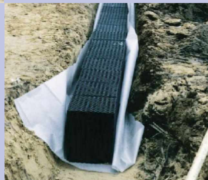
Przykładowa instalacja skrzynek AquaBlok w wykopie
