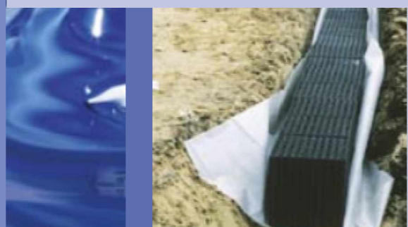
Sposób układania AquaBlok®-ów w wykopie
